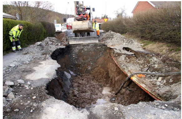
Reparation av vattenläcka pågår. Bildkälla: VA-Fakta
